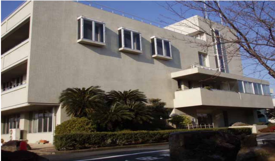
岡山県南部水道企業団 庁舎
